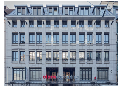
Greifengasse 36, 38 / Rebgrasse 6 Basel
