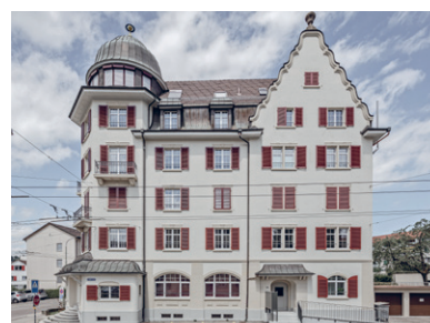
Lindenstrasse 155 / Kesselhalden- strasse 2 St. Gallen
